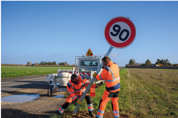
Pose d'un panneau de limitation de vitesse
