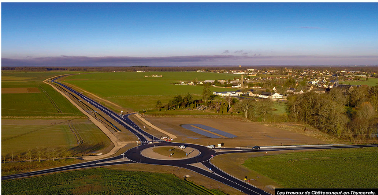
Les travaux de Châteauneuf-en-Thymerais.
